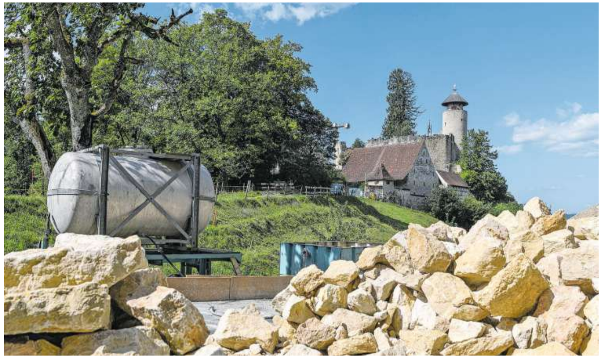
Renovation: Bis Oktober dauern die Arbeiten am Schloss Birseck.
