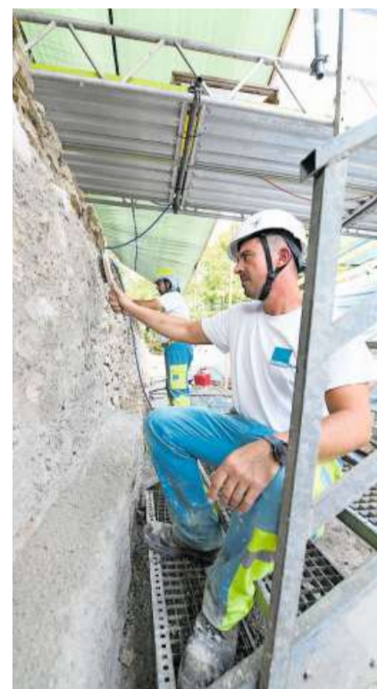
Spezielles Handwerk: Jeder Stein wird akribisch freigelegt und inspiziert.
